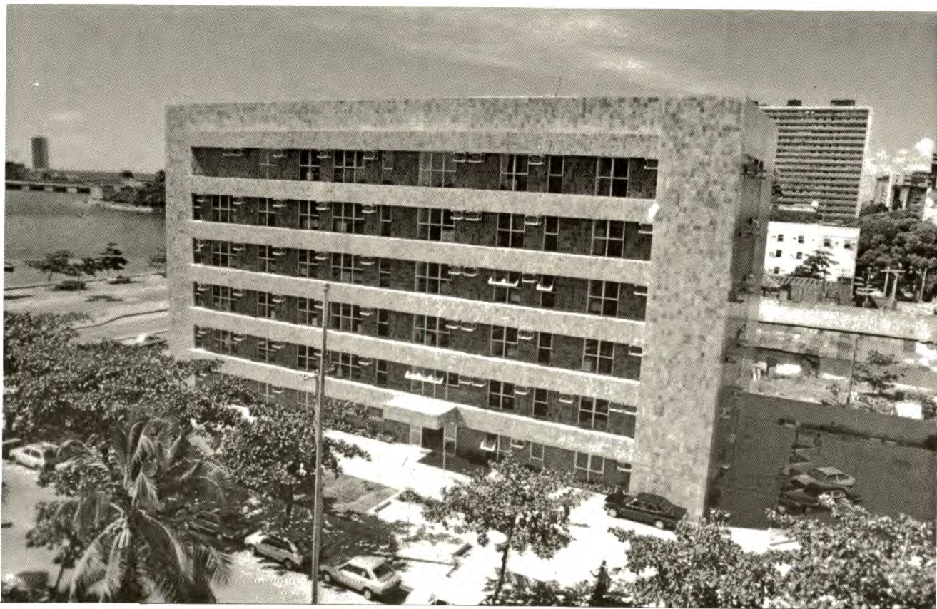
Edifício-Sede do Tribunal de Contas do Estado
